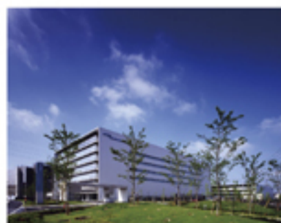
研究開発センター・本社 R&D center Headquarters
